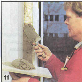
11 Излишки застывшей монтажной пены обрезают так, чтобы шов было чисто заштукатурить.
