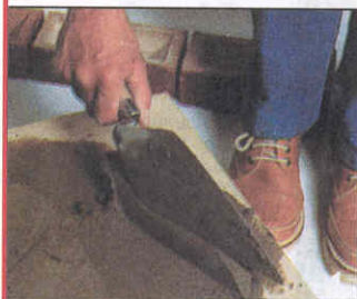
Плавными движениями отсекают кельмой порцию раствора (размером примерно с лопатку кельмы).
