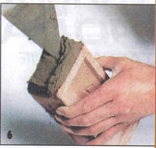
Держа кирпич вертикально, подрезают раствор на кромках. Толщина слоя должна быть равномерной и составлять 10–12 мм.
