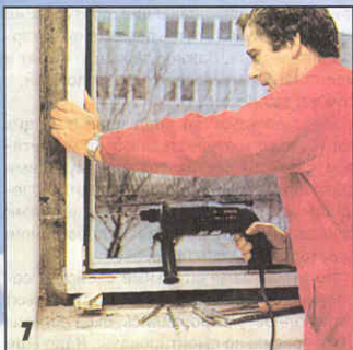
7 Сквозь оконную коробку в стене сверлят отверстия для рамных дюбелей.
