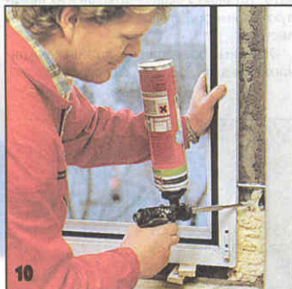
10 Закрепив коробку, щели между ней и откосами проема заполняют монтажной пеной.
