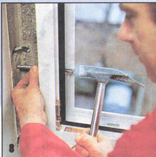
8 Длинные металлические дюбели обеспечивают надежное крепление коробки в оконном проеме.
