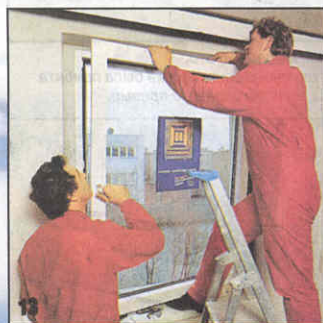
В заключение навешивают открывающиеся створки. Чем точнее будет выверено их положение, тем плотнее будет закрываться окно.
