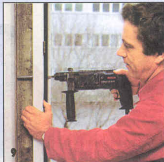
9 Для ввертывания в дюбели винтов можно использовать электроинвертер или электродрель, имеющую соответствующий режим работы.
