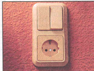
В комбинированных блоках в одном корпусе могут быть собраны до пяти выключателей и штепсельных розеток.
