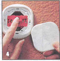
Выключатель вставляют в коробку в гнезде стены и разжимают боковые фиксаторы, затягивая установочные винты.
