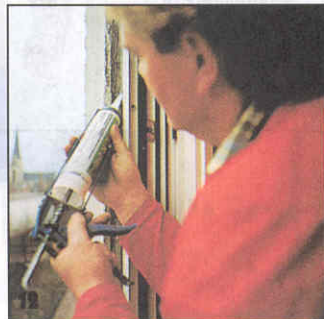
Тщательное уплотнение наружного шва силиконовым герметиком надежно защитит окно от проникновения дождевой воды, а монтажную пену — от солнечных лучей.
