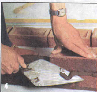
Укладывают кирпич в кладку и удаляют выступившей из шва раствор, поддев его краем кельмы снизу вверх.
